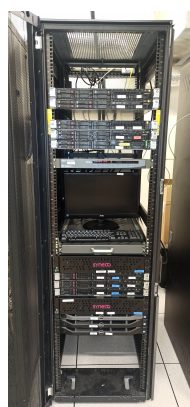
FIGURE 6 – La baie du Crans, montée et remplie en SQ39 le soir du déménagement
